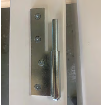
Türpfosten mit vormontiertem Fitschenband- Unterteil mit Dorn
