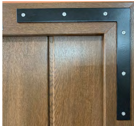
Versteifungswinkel am Türblatt zur zusätzlichen Stabilisierung der Ecke
