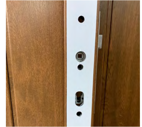
Ausfräsungen im Rahmen eines Türblatts für die Drückergarnitur
